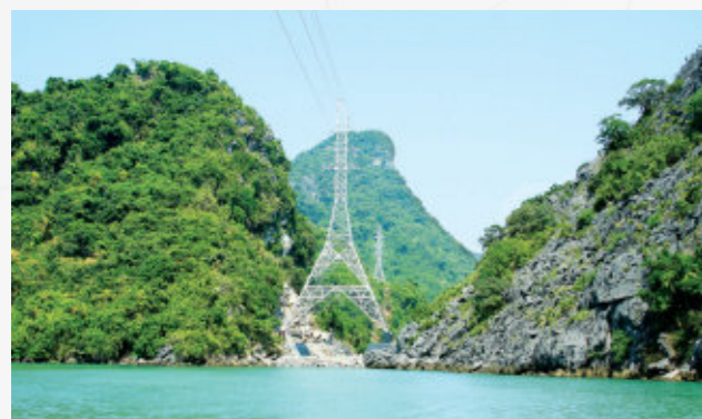
ĐZ 110kV đưa điện ra huyện đảo Cô Tô - Quảng Ninh
