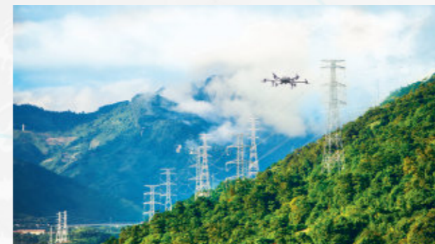
ĐZ 500kV Sơn La - Hòa Bình - Nho Quan (Khối Xây lắp điện)
